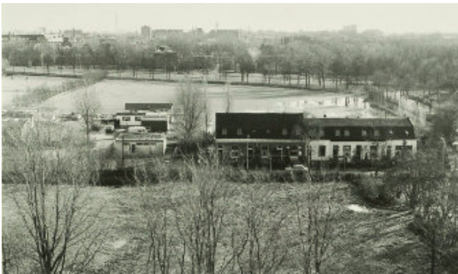
▲ Arbeiderswoningen aan de Dompvloedslaan die in 1989 werden afgebroken
